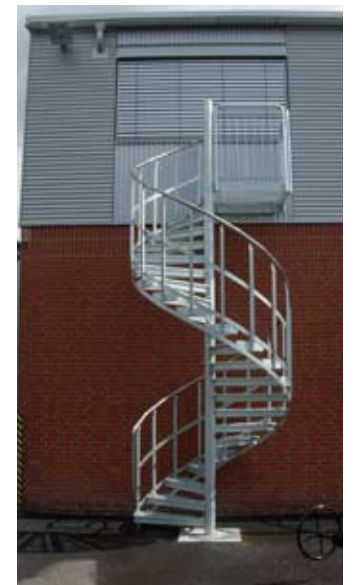
Auch Treppen, wie hier eine Außenanlage, oder gar große Treppenhäuser für Kreuzfahrtschiffe werden in Burlage hergestellt.
