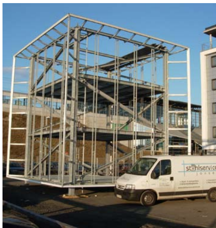
Selbst große, komplizierte Stahlkonstruktionen sind für das Unternehmen Stahlservice Jansen kein Problem.
